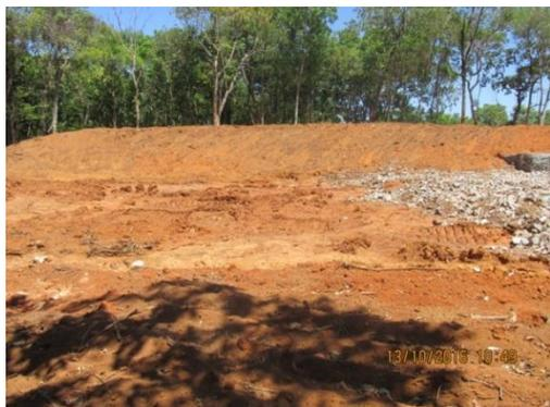
Talude sem cobertura vegetal e ponto de lançamento da drenagem.
